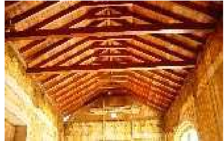
Vistas de la reconstrucción de estructuras de “par y nudillo” con piezas de madera de algarrobo, 2002.
