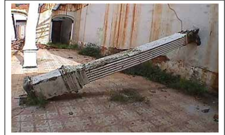
Centro de Amigos en 2001, desaparición de los techos y Estado ruinoso en que se encontraba antes de su intervención.
