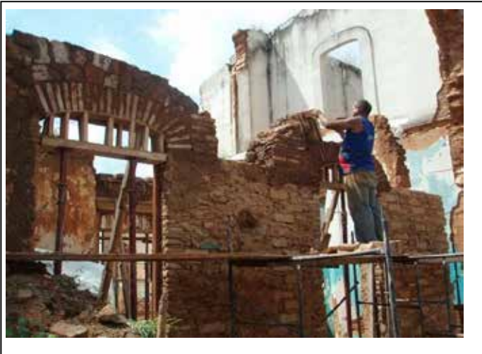
Vistas de la restauración y reconstrucción de arcos y columnas de ladrillos, así como de los muros de adobones con tierra cruda reciclada
