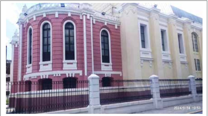
Vista de volumen curvo y fachada lateral
