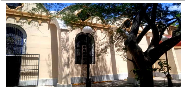
Vistas de las Fachadas Laterales.
